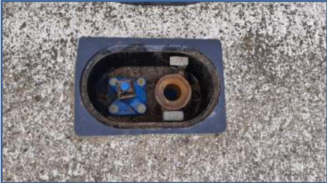
Fotografía. 1. Boca de riego modelo Pampona. Racor columna.
